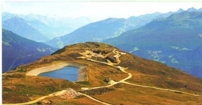
Mit einer Tiefe von ca. 14 m und einem Speichervolumen von über 220.000 m<sup>3</sup>, ermöglicht der Speicherteich Frommes II in der Region Serfaus Fiss Ladis eine Verdoppelung der Beschneigungsmenge.
